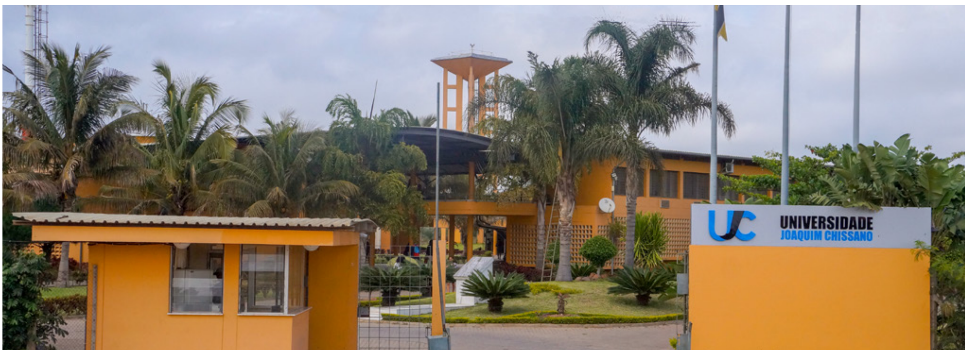
Fachada principal da Campus do Zimpeto-Fotografia de arquivo
